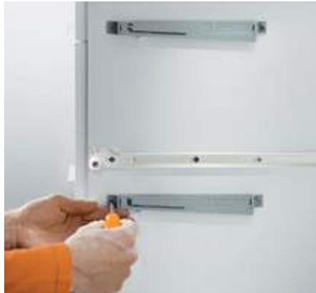
Un montage sur un seul côté suffit : l'installation d'une seule unité BLUMOTION est nécessaire jusqu'à une largeur de corps de meuble de 900 mm.
